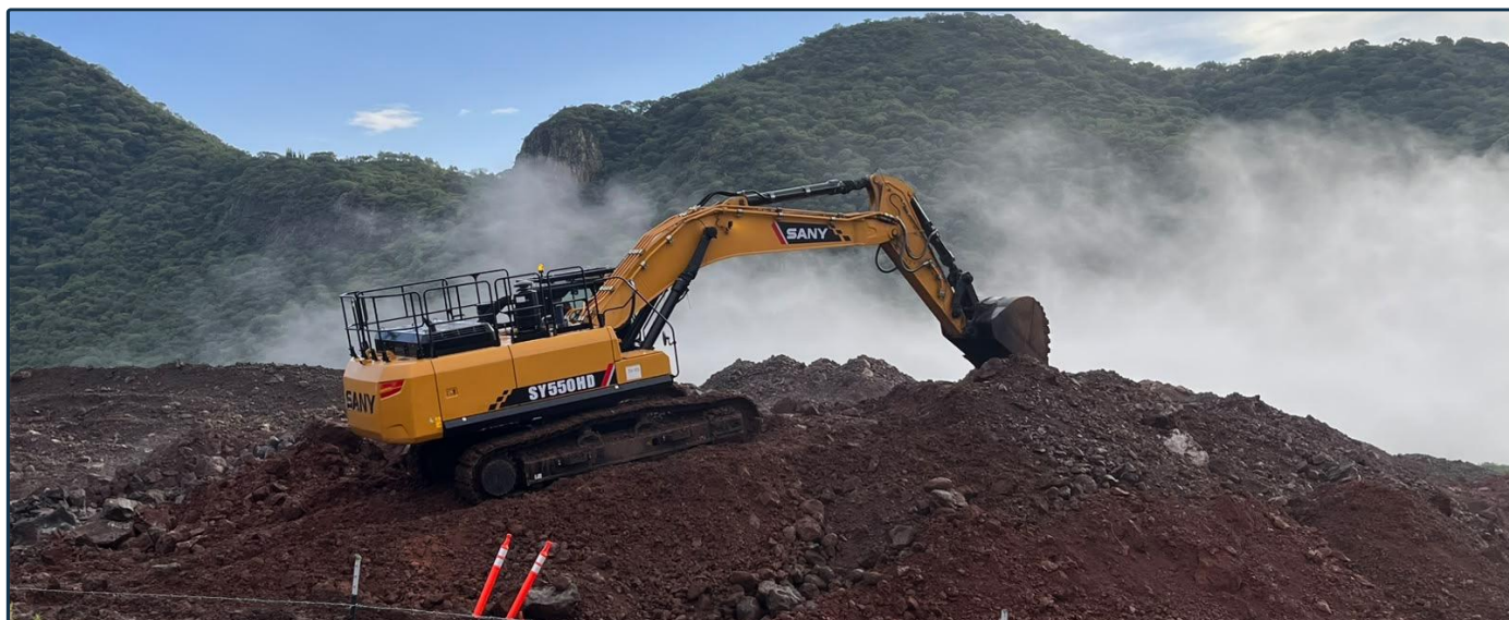
Imagen 1 — Vista general de los trabajos de corte y clasificación de material bajo condiciones de niebla en el área.
