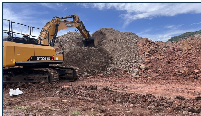
Imagen 6 — Excavadora apoyando en la realización de un muestreo.
