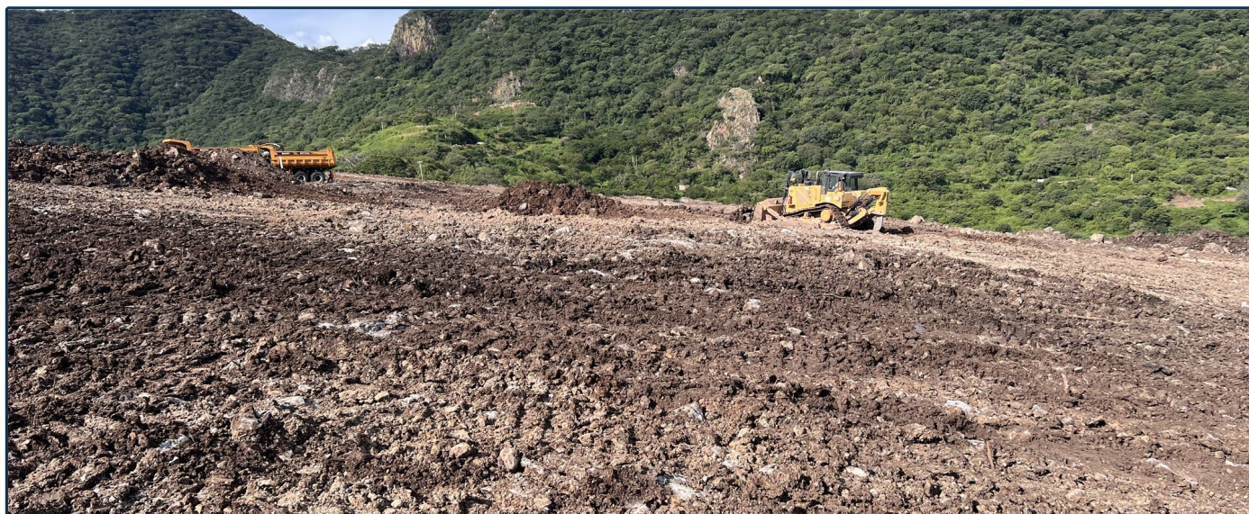
Imagen 4 — Tractor retirando material contaminado (con presencia de material orgánico) del área de trabajo.
