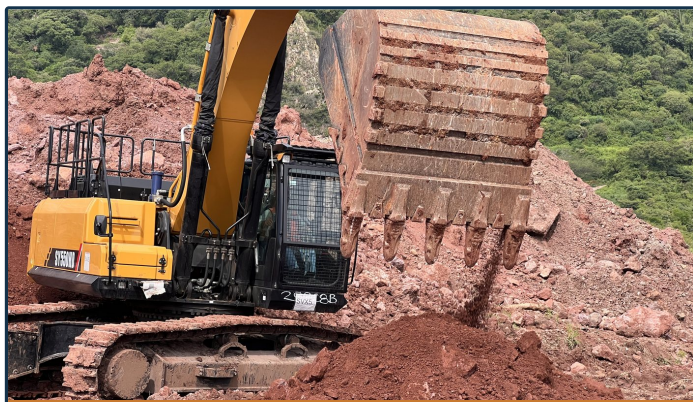
Imagen 2 — Excavadora (SANY SY550HD) aflojando el material para la toma de una muestra representativa.
