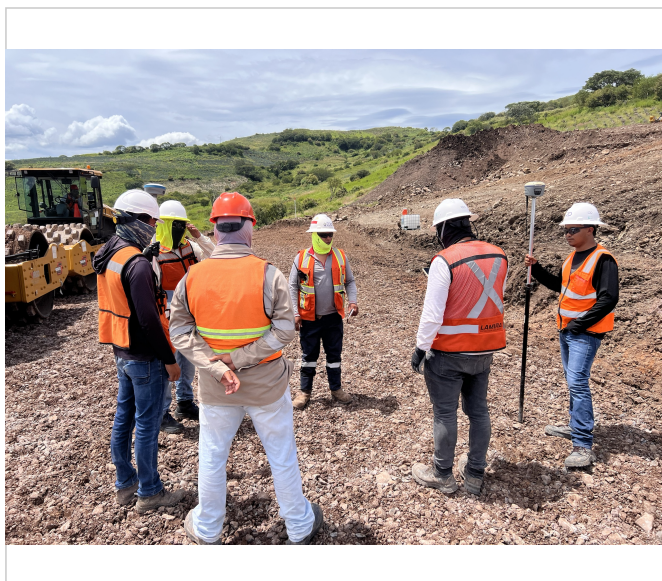
Control topográfico de la capa con equipo GNSS
