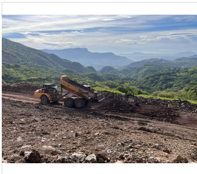
Suministro y descarga de material para capa siguiente
