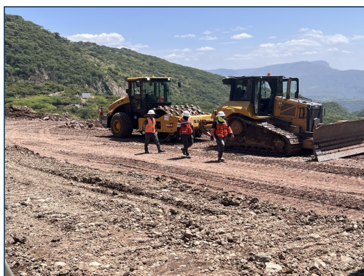
2. Equipo empleado en los ciclos de compactación: vibrocompactador pata de cabra y tractor D5.
