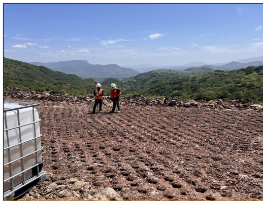
5. Control topográfico durante los ciclos de compactación.
