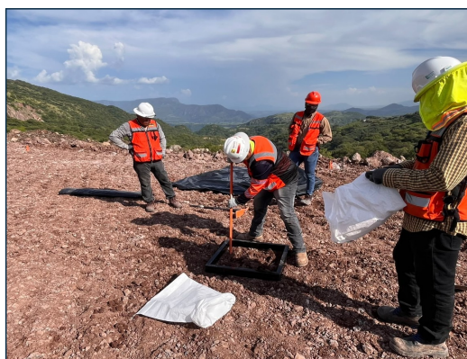
3. Preparación de la prueba de densidad de campo por reemplazo de agua.
