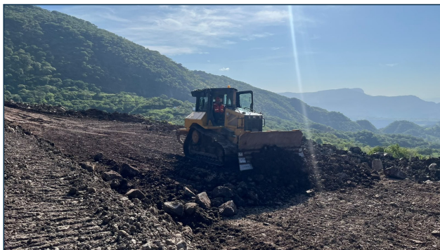
1. Conformación de la Capa 11 y capa de prueba con tractor sobre orugas.
