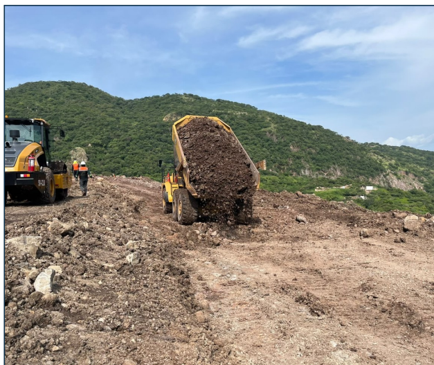
2. Descarga de material y vibrocompactador tipo pata de cabra en la plataforma de prueba.
