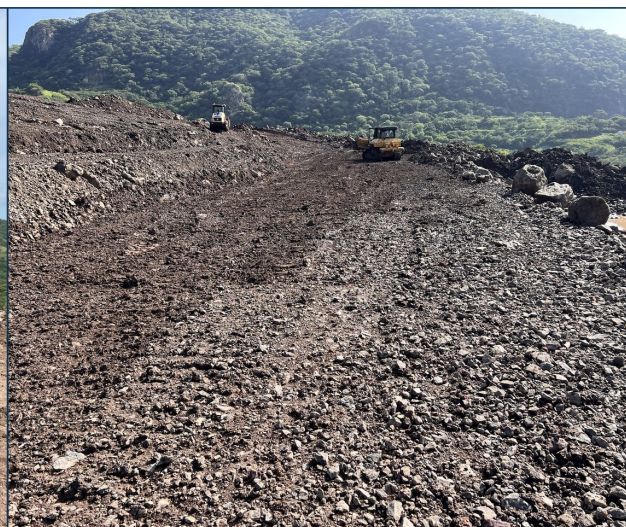
3. Vista general de la plataforma de prueba en conformación.
