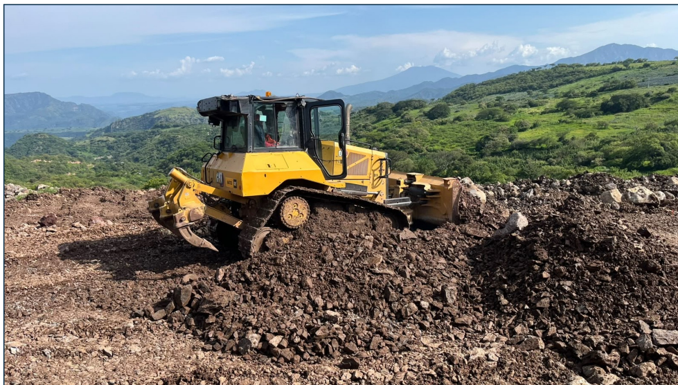
1. Tendido y distribución de material con tractor sobre orugas.
