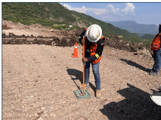
4. Prueba de densidad de campo — método del cono de arena.
