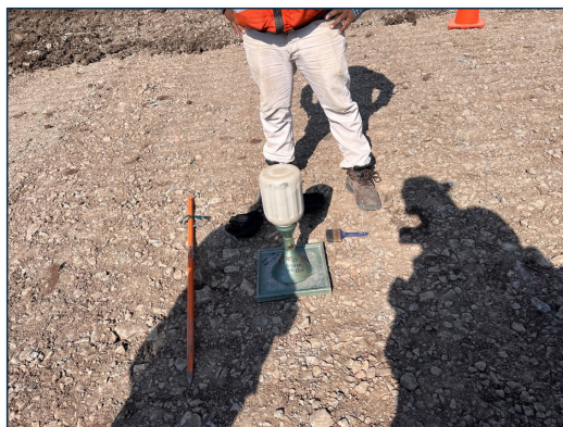
5. Prueba de densidad de campo — detalle del cono de arena.
