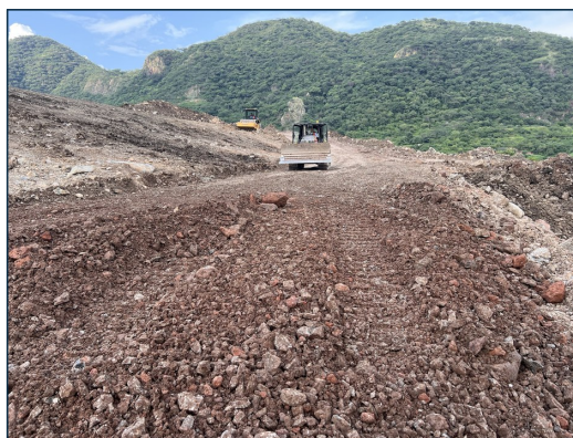
3. Compactación con vibrocompactador tipo pata de cabra.
