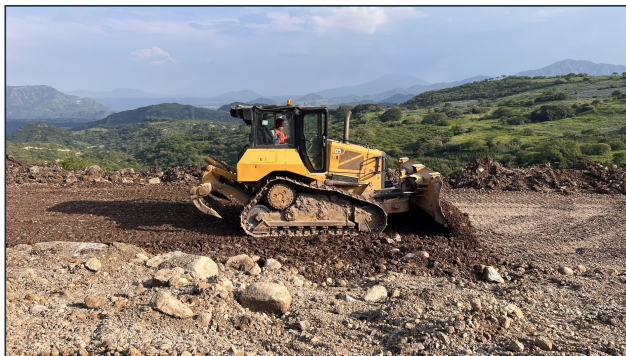
1. Tendido y bandeo de material con tractor D8.
