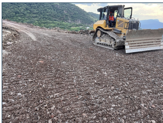
2. Distribución y acomodo de material con tractor D8.
