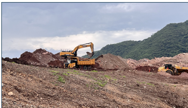
1. Suministro de material de naturaleza rocosa para conformación de capas.
