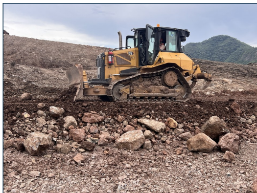
2. Extendido y conformación de material con tractor D5.
