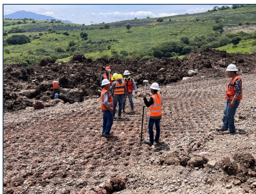
4. Verificación de calidad y topografía en el tramo ejecutado.
