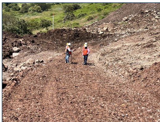
5. Control topográfico de las capas liberadas.
