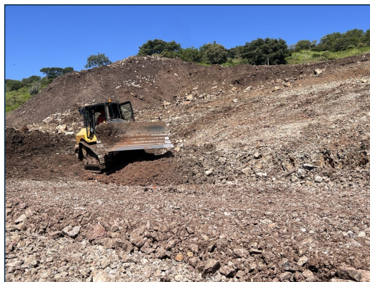
3. Bando y acomodo del material en capa.
