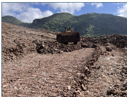
5. Capa 3 conformada con tractor D8.
