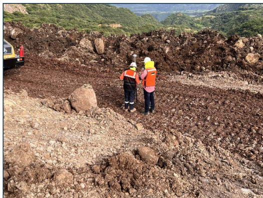
2. Conciliación de datos con topografía en el tramo de prueba.
