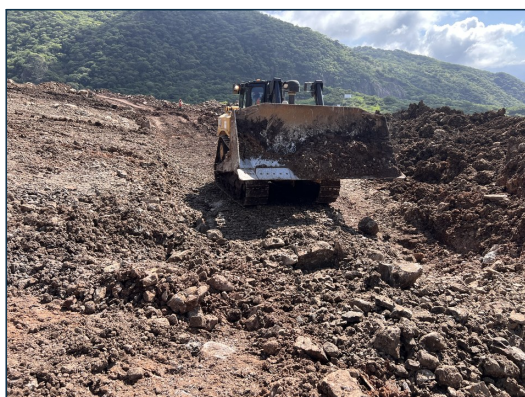
4. Homogeneización del material con tractor D8.
