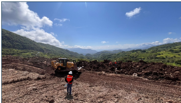
1. Vista general de la capa de prueba con tractor D8; equipo de topografía en el área.
