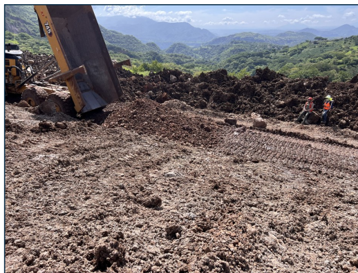
3. Descarga de material para los escalones de liga.
