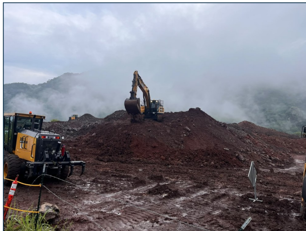
2. Maquinaria realizando abundamiento de material en el área de trabajo.
