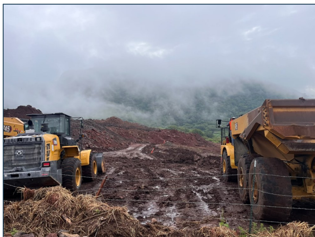
3. Equipo de carga y acarreo de material.
