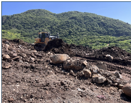
2. Recorrido de campo — condiciones previas al desplante.
